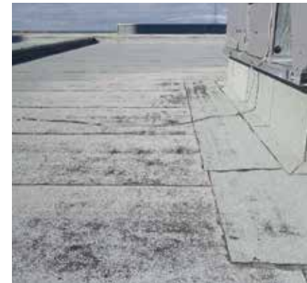
USURE PRÉMATURÉE DES MEMBRANES
