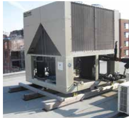
APPAREIL DE MÉCANIQUE DE PLUS DE 70 KG (150 LB) DÉPOSÉ SUR LA COUVERTURE
